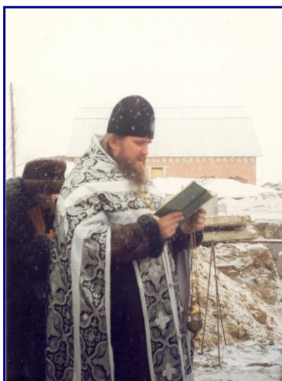
Отец Сергей освящает катлован под строительство Воскресной школы
